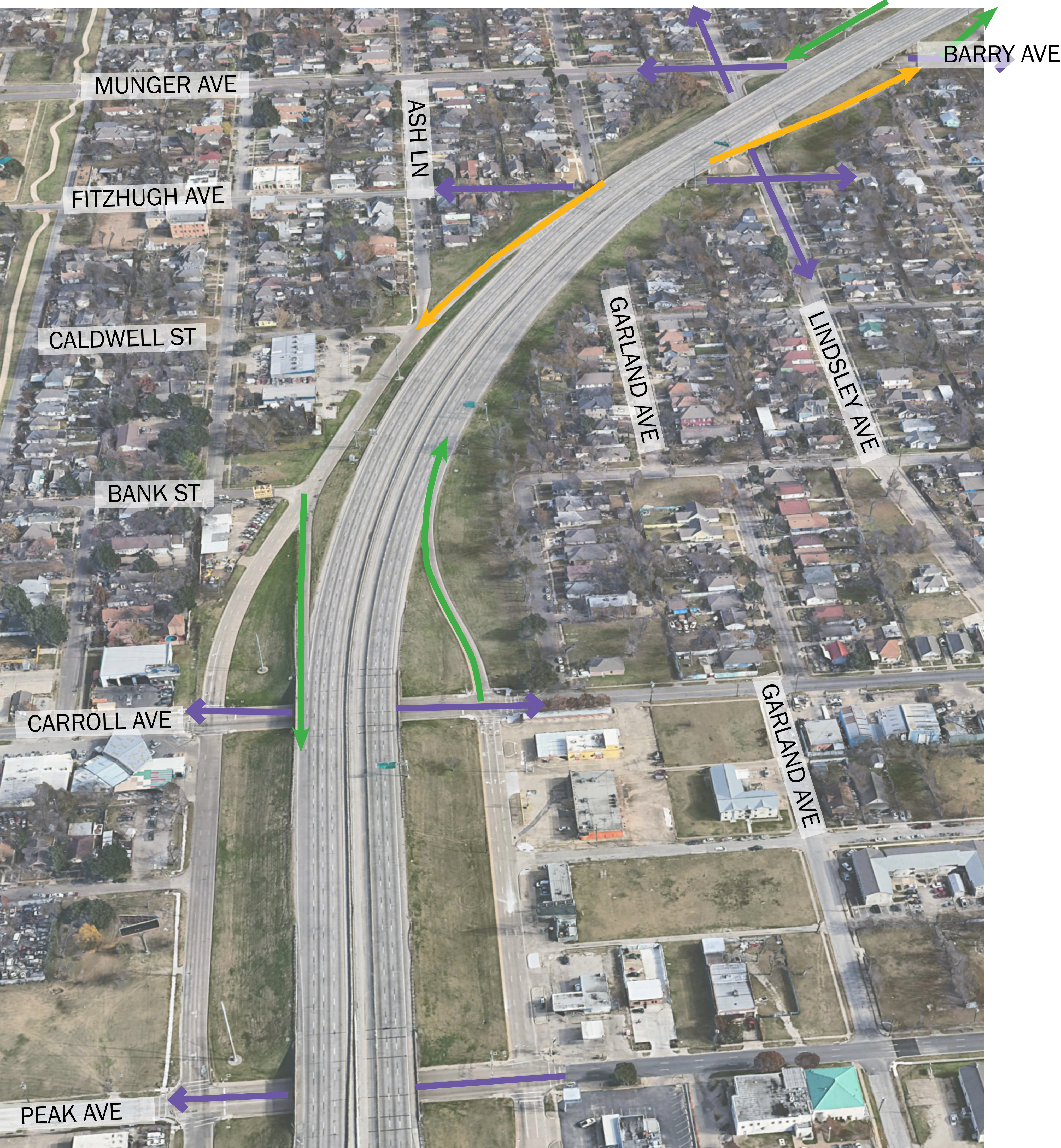
Existing I-30 (existente I-30)
